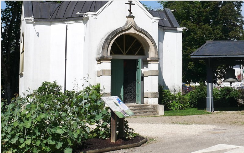
Chapelle orthodoxe dans le parc thermal de Contrexéville (Amis saint Colomban)
