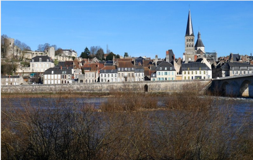
Vue générale de La Charité sur Loire depuis la rive gauche de la Loire (Amis de saint Colomban)
