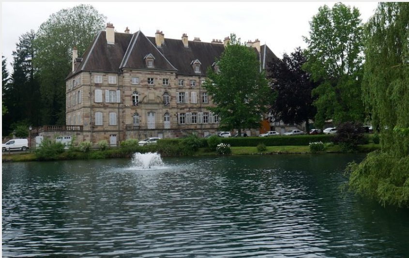
Bâtiment conventuel de l'ancienne abbaye de Lure (Amis saint Colomban)
