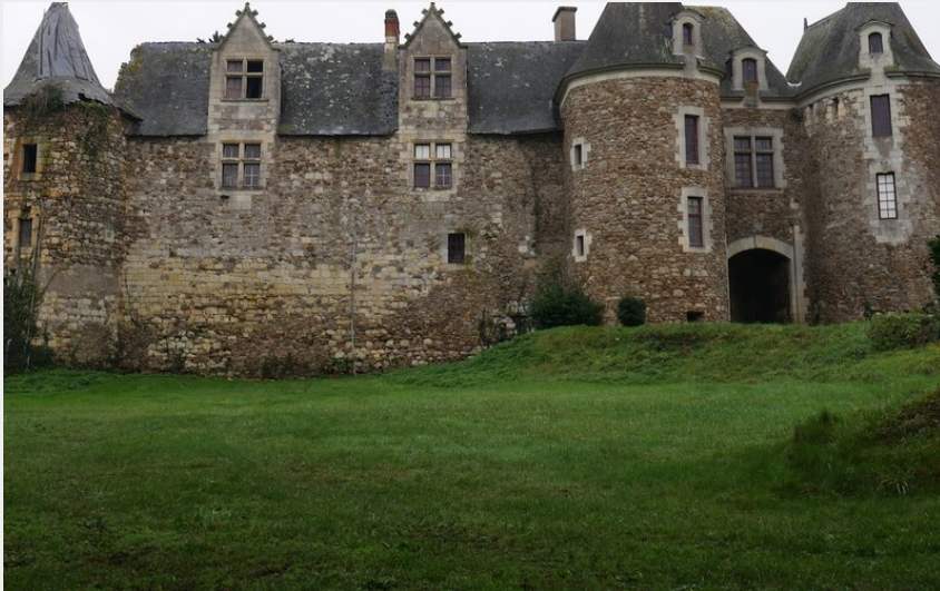
Château de Blaison-Gohier (Amis saint Colomban)
