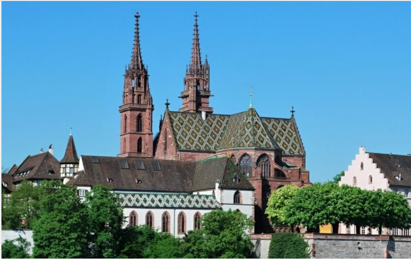
La cathédrale Notre-Dame de Bâle avec son toit en tuiles vernissées. (Cath.ch)
