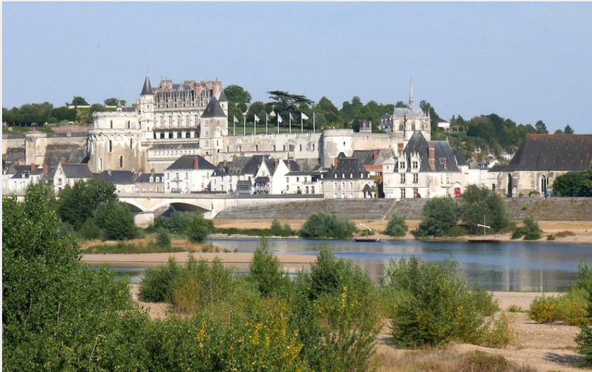
Vue générale d'Amboise depuis la rive droite de la Loire (Amis saint Colomban)
