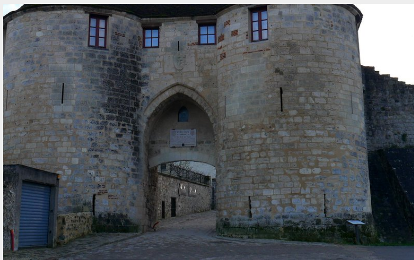
Porte Saint-Jean du château médiéval de Château-Thierry (Association Colomban en Brie)
