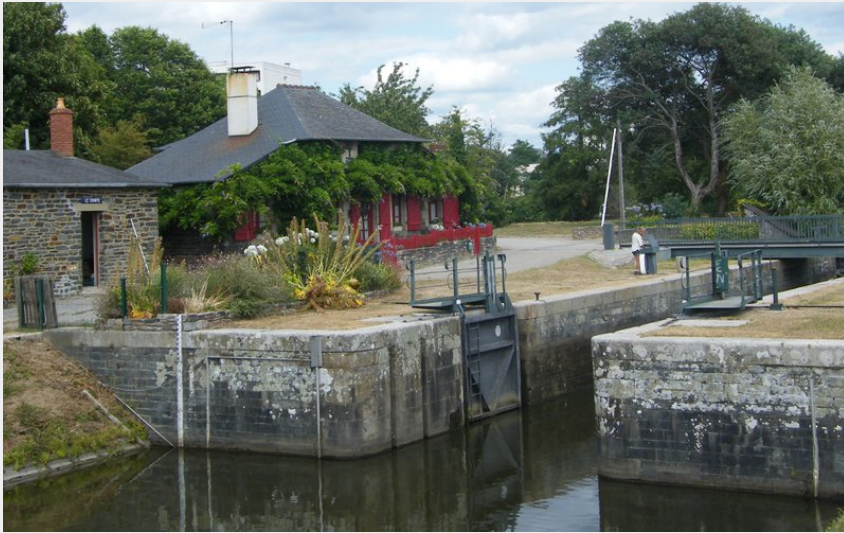
Ecluse sur La Vilaine (Amis Bretons de Colombran)
